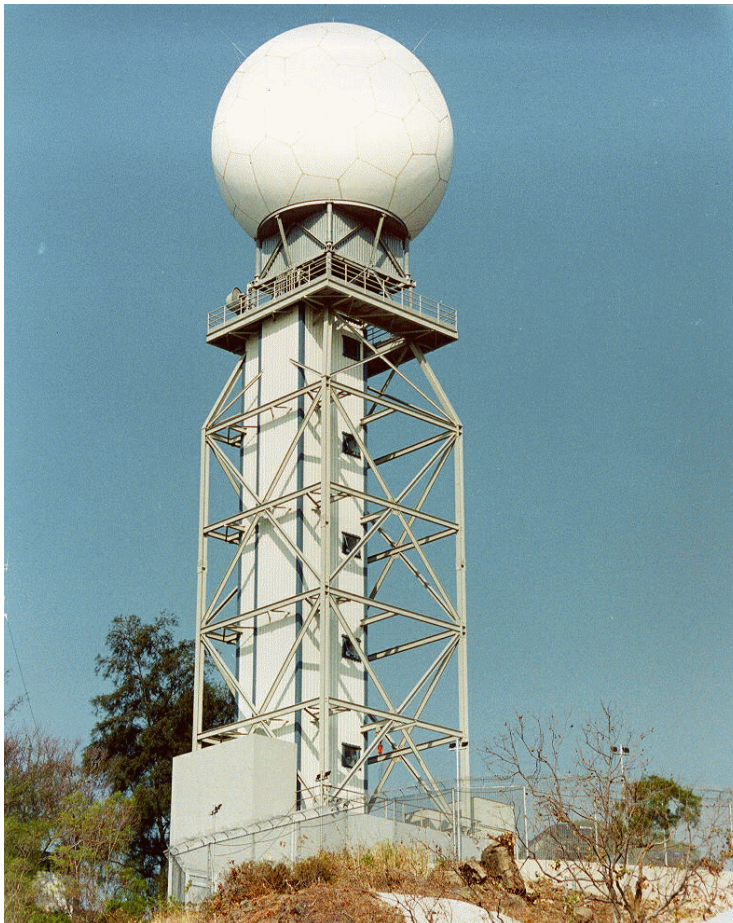
Рис. А4-7. Аэродромный доплеровский метеорадиолокатор в Гонконге
